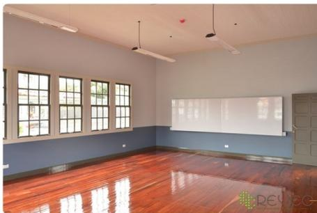
Cielos y pisos de madera y mosaico restaurados en su totalidad. Para conservar su diseño original se cambiaron las puertas de metal por madera, y se reconstruyeron marcos de ventana. Construcción de dos aulas y el comedor, instalación eléctrica nueva para todo el edificio, fueron solo algunos de los trabajos a los que fue sometido el edificio.
